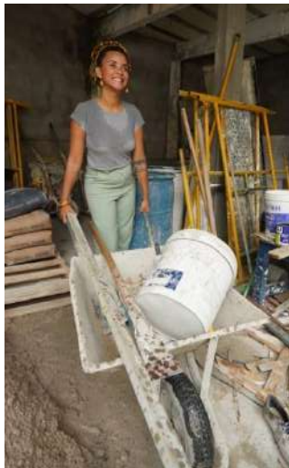
Auf der Baustelle
